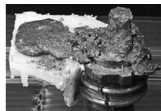
Figura 14 – Foto de un terminal de batería derretido
